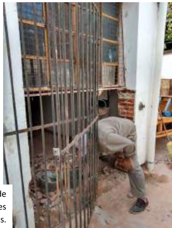
Colocación de bomba de agua sumergible
