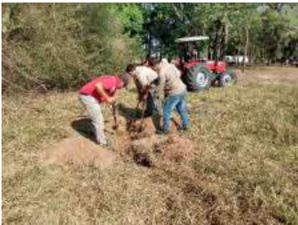
Cambio de ubicación del medidor de agua
