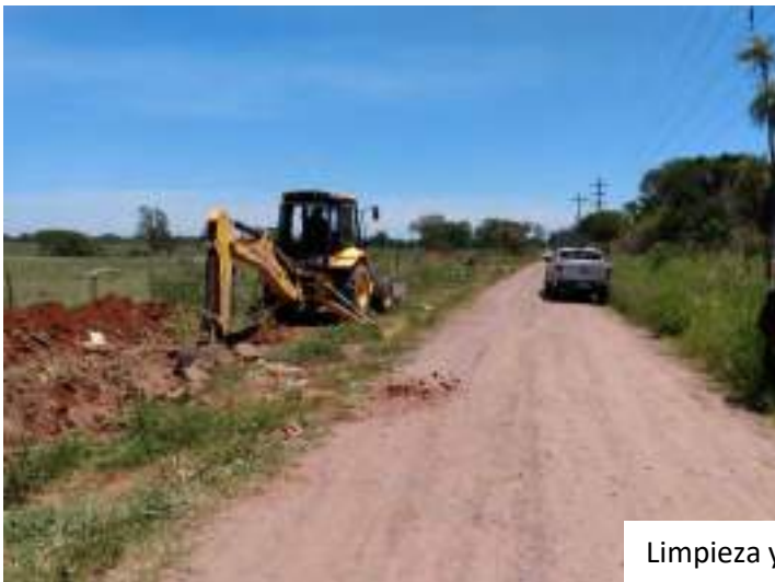
Coordinación en terreno con subsecretario de Relaciones Institucionales de la Municipalidad para llevar las tareas de zanjeo y limpieza.
