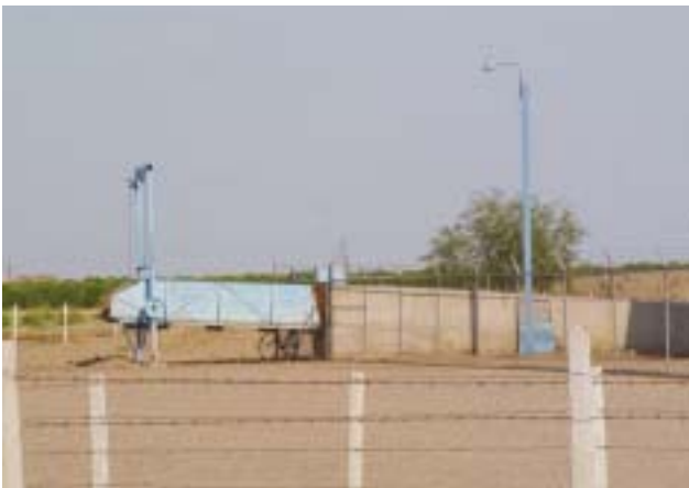
Rampa de carga
