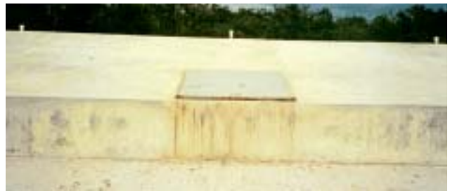
Pits de concreto
